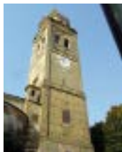
Torre dell'Abbazia di San Tommaso
