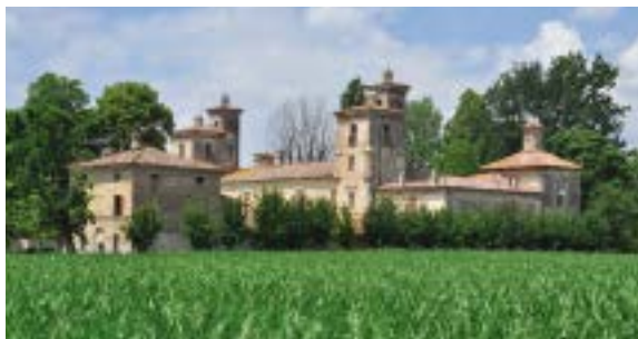
Casteldidone Villa Mina della Scala
